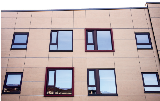
Fasaden har Swisspearl fasadeplater i tre ulike farger. Parkeringskjelleren nederst har vegger av prefabriserte betongelementer.
