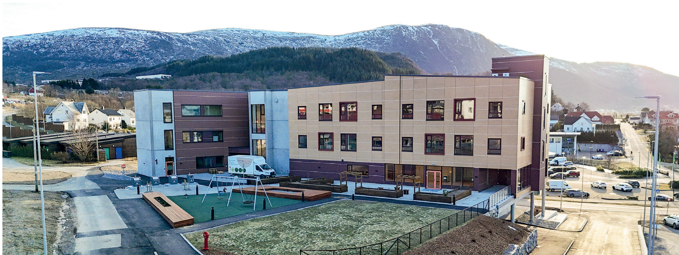
Skollebakken omsorgsboliger sett fra hovedinngangspartiet mot nord. Her ser vi også uteområdet som er en del av prosjektet.
