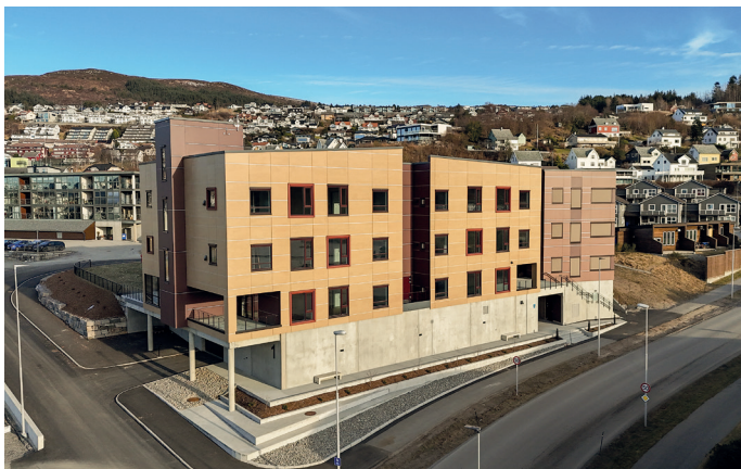
Fasaden har Swisspearl fasadeplater i tre ulike farger. Parkeringskjelleren nederst har vegger av prefabriserte betongelementer.
