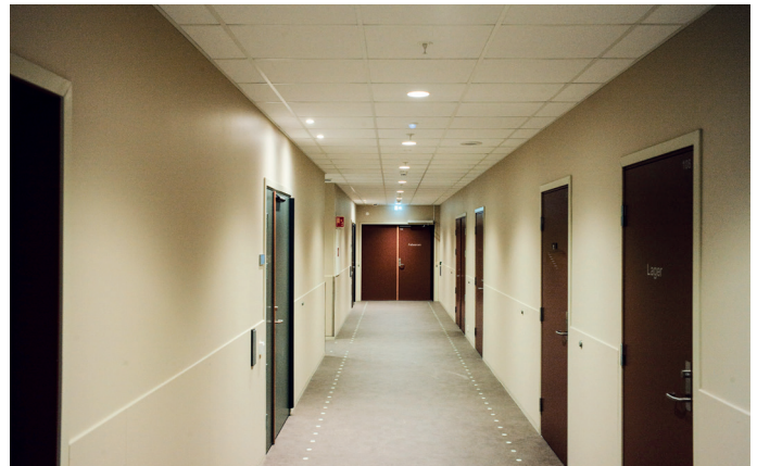
Nedre del av veggen i gangarealene er forsterket med ekstra plater.
